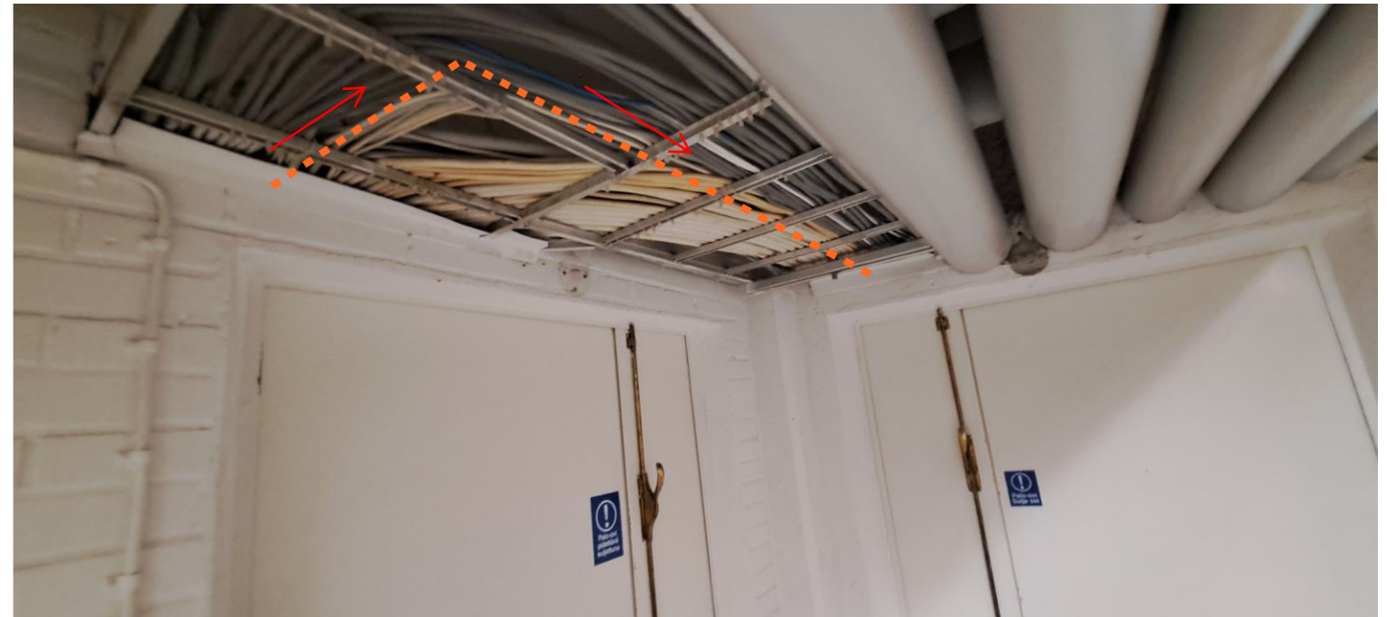
Sisäkaapelin asennus kaapelihyllylle.
