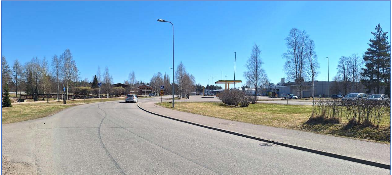
Kuva 17. Näkymä Toritietä etelään eläinlääkäritalon kohdalta.
