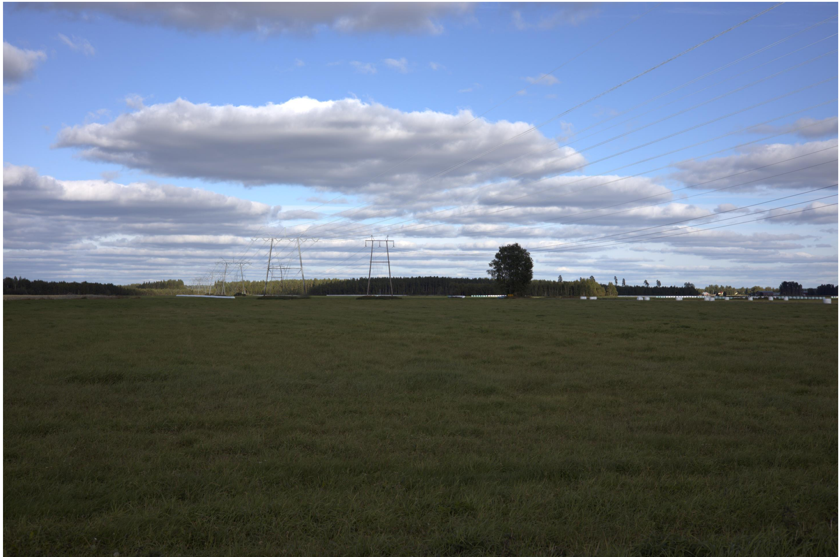
Kuva 119. Kuvauspiste 1. Havainnekuva SVE3a/SVE3b-sähkönsiirtoreittien ilmajohdosta reittien loppuosasta läheltä Vääräjokea. Kuvassa näkyvä oikeanpuoleisin johtopylväs on olemassa olevan ilmajohdon pylväs, ja vasemmalla näkyvät johtopylväät mallinnettuja SVE3a/SVE3b-reitin johtopylväitä.
