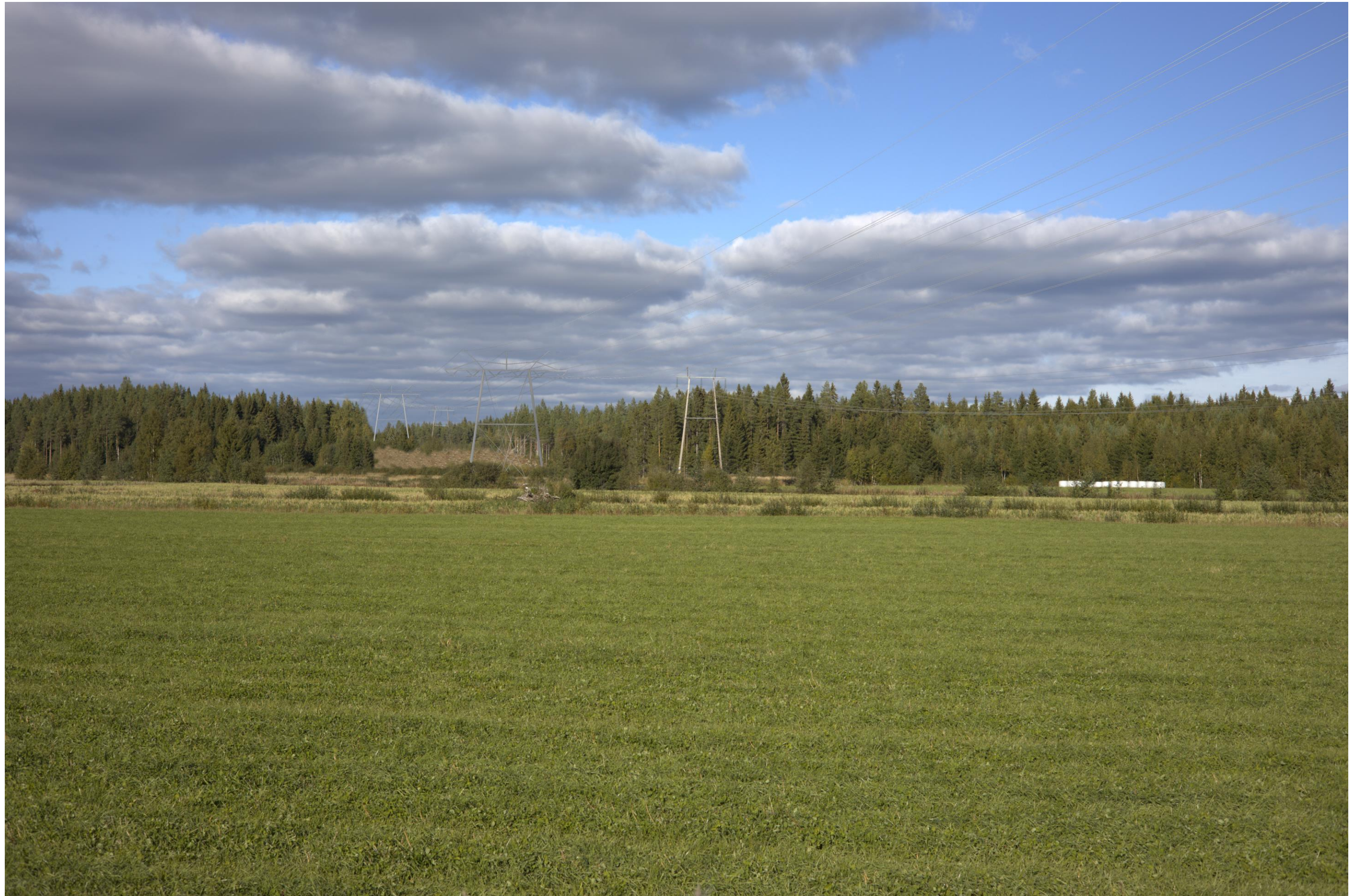
Kuva 117. Kuvauspiste 2. Havainnekuva SVE3a-sähkönsiirtoreitin ilmajohdosta Rautiontieltä läheltä Vasaman pihapiiriä. Kuvassa näkyvä oikeanpuoleisin johtopylväs on nykyisen ilmajohdon pylväs, ja vasemmalla näkyvät johtopylväät mallinnettuja SVE3a-reitin johtopylväitä.
