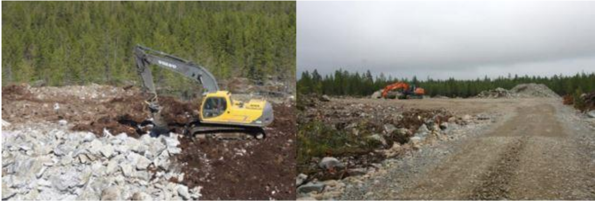
Kuva 4.17 Tuulivoimapuiston rakentaminen alkaa huoltoteiden ja pystytysalueiden rakentamisella (FCG).
