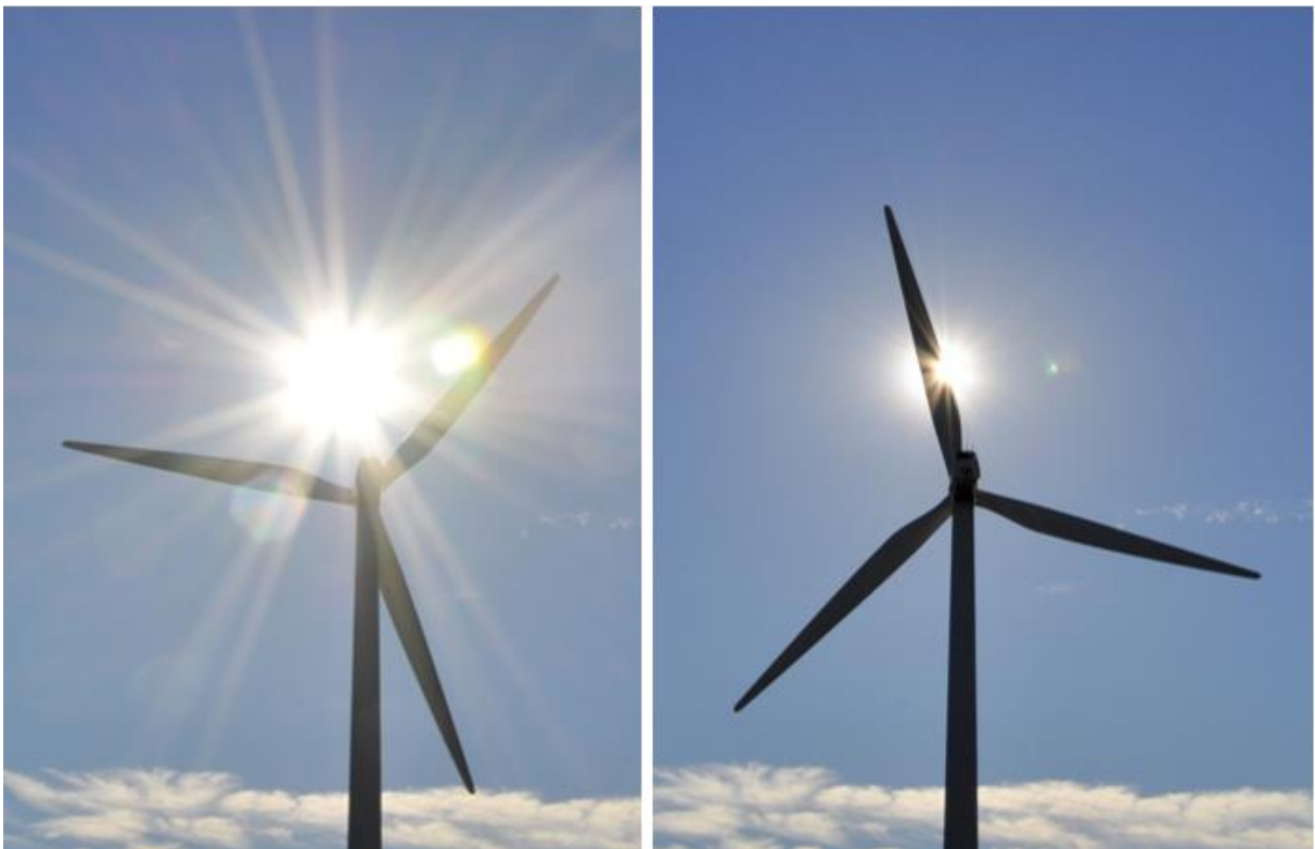
Kuva 16.14 Tuulivoimaloiden lavat aiheuttavat pyöriessään vilkkumista ja varjon välkkymistä aurinkoisella säällä.
