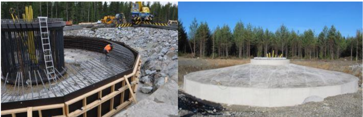
Kuva 4.19 Tuulivoimalan perustusten rakentamista (FCG).
