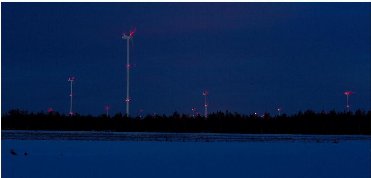
Kuva 4.4 Kiinteät punaiset lentoestevalot (FCG).
