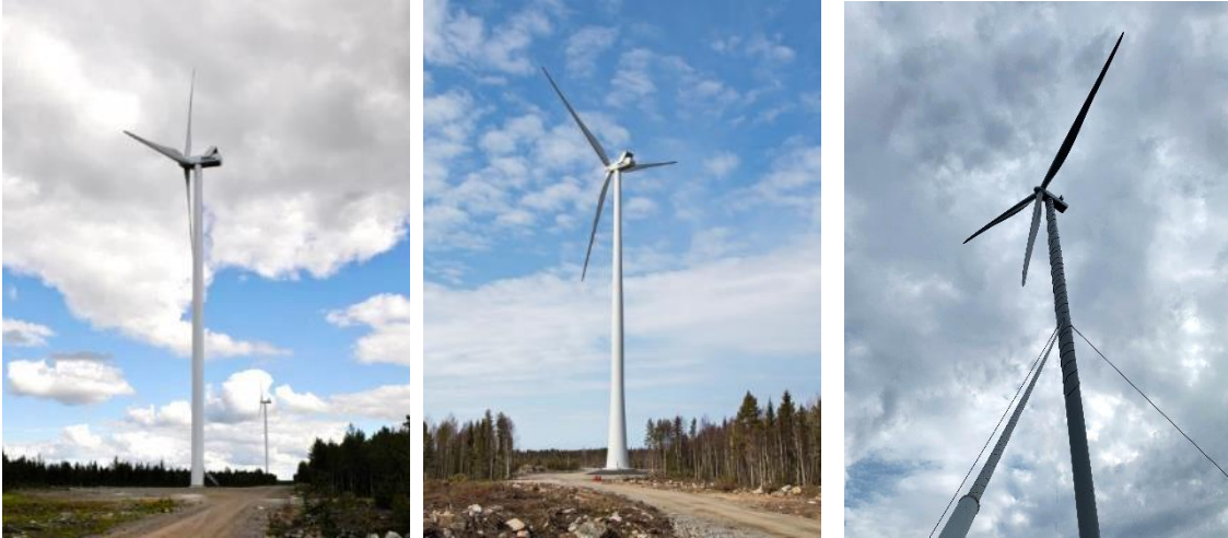
Kuva 4.2 Vasemmalla on esimerkki teräslieriötornista, keskellä hybriditornista ja oikealla harustetusta tornista. (Kuvat: FCG sekä Jarkko Finnilä, Carelin).
