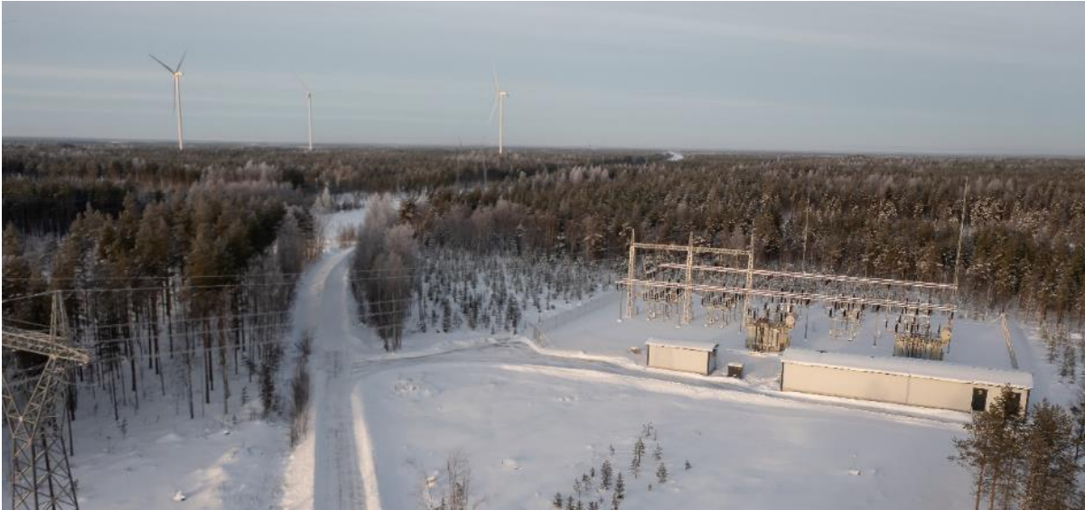
Kuva 4.16 Esimerkki tuulivoimapuiston sähköasemasta (FCG).
