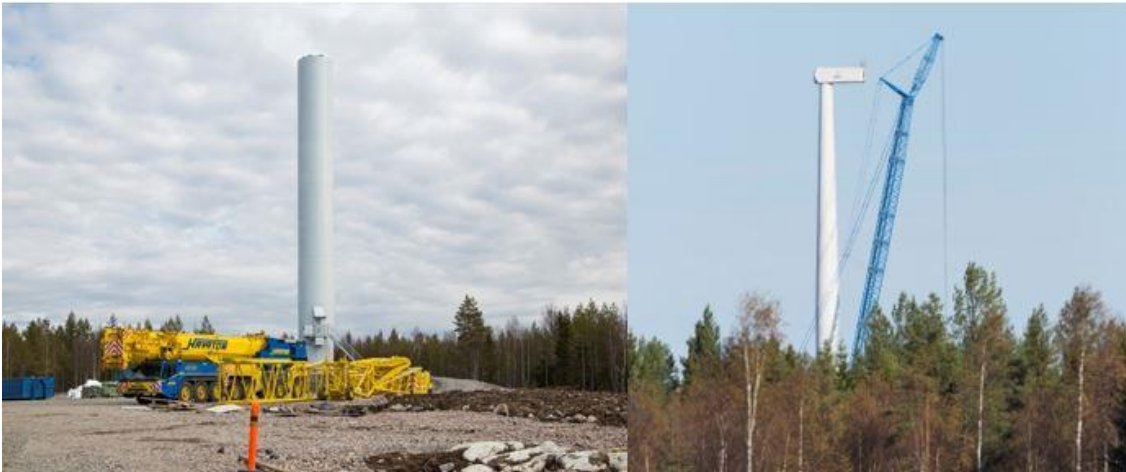
Kuva 4.20 Tuulivoimalan kokoamista (FCG).
