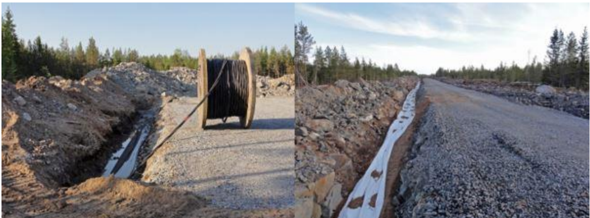
Kuva 4.18 Maakaapelit upotetaan huoltoteiden yhteyteen (FCG).
