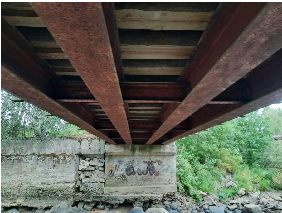
Yleiskuva sillan alta
