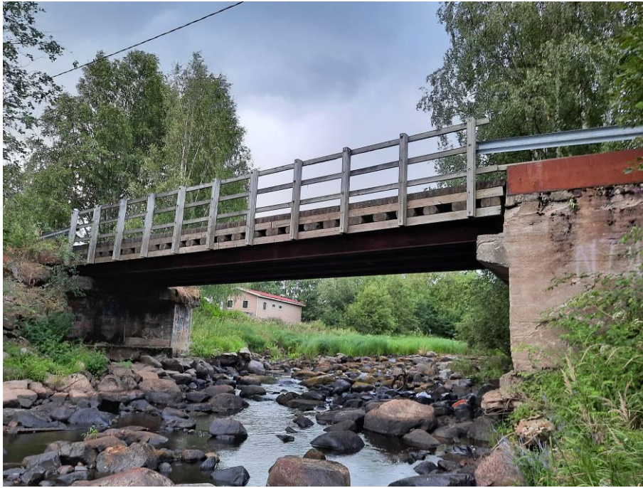
Yleiskuva vasemmalta puolelta
