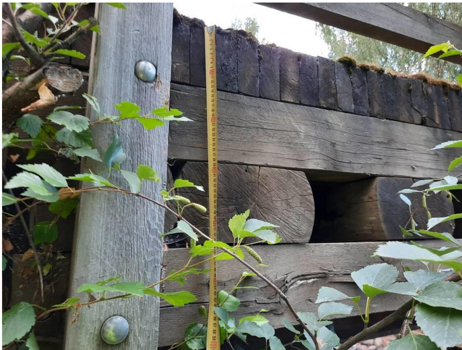
Kuva 9 päällysrakenteen puiset osat
