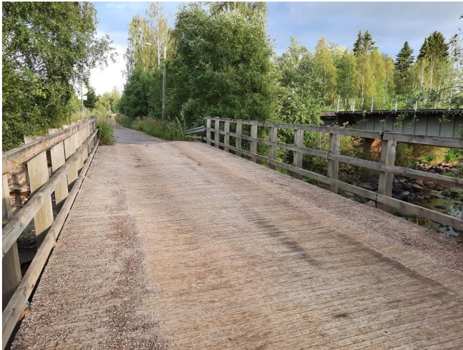
Kuva 8 syrjälankkukansi
