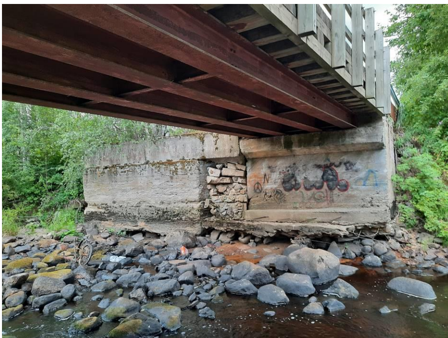
Kuva 2 päätytuki 1 sillan oikealla puolella (ylävirta) kivirakenteinen tukimuri, jonka jatkeena betonirakenteinen tukimuri.
