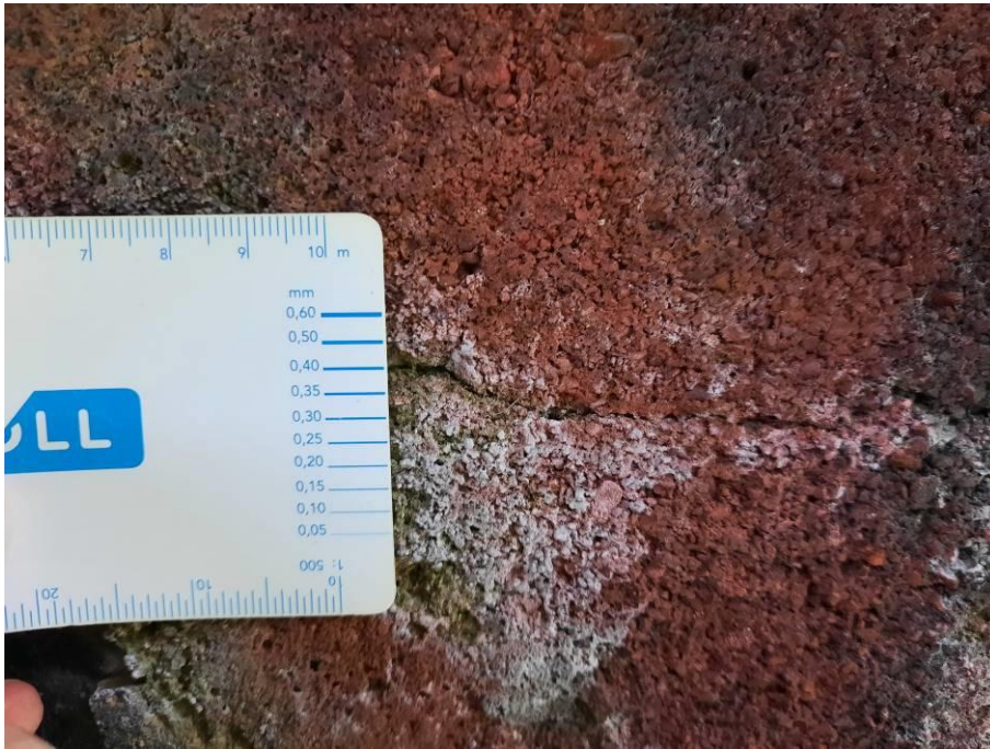
Kuva 5 etumuurien suuntaumatonta halkeilua
