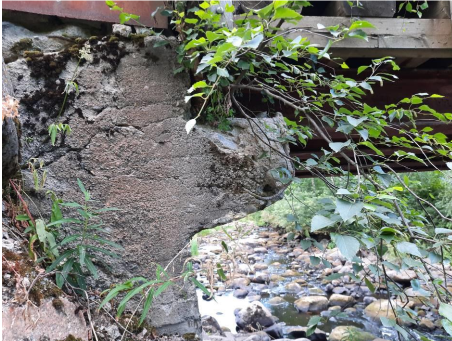
Kuva 3 laakeripalkki ja siipimuuri 2 vasen erittäin vakavaa rapautumaa. Laakeritasolla kasvaa koivu.
