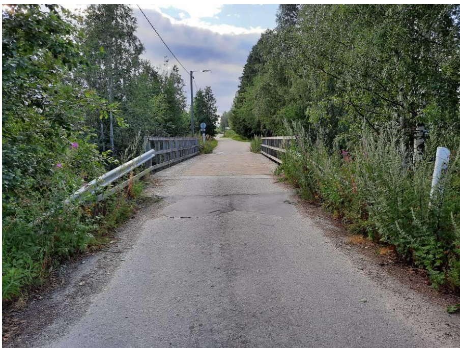
Kuva 14 Pengerkaiteet ovat liian matalat ja lyhyet.
