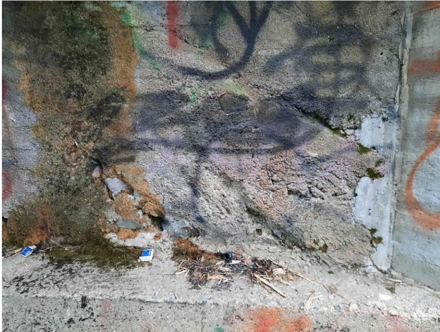
Kuva 7 etumuurien harvavalua
