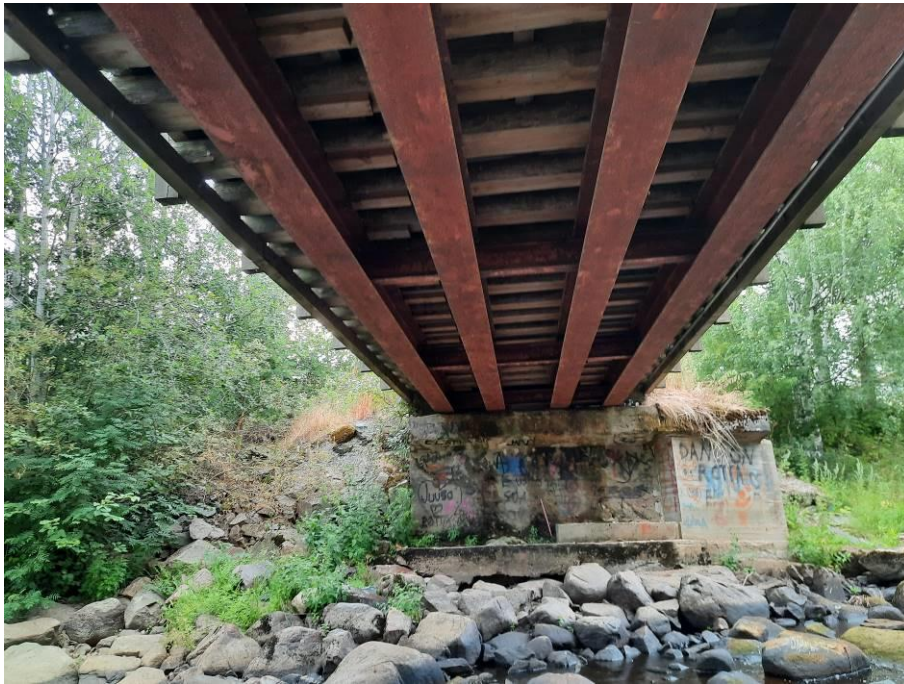
Kuva 10 ruostuneita teräspalkkeja
