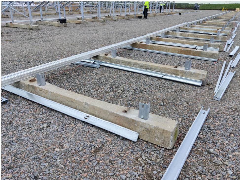
Kuva 3-3. Aurinkopaneelin perustusten mitoitus ja periaate (Skarta Energy Oy 2023). Perustukset on tarkoitus asentaa Hituran alueella suoraan kasvukerroksen päälle.
