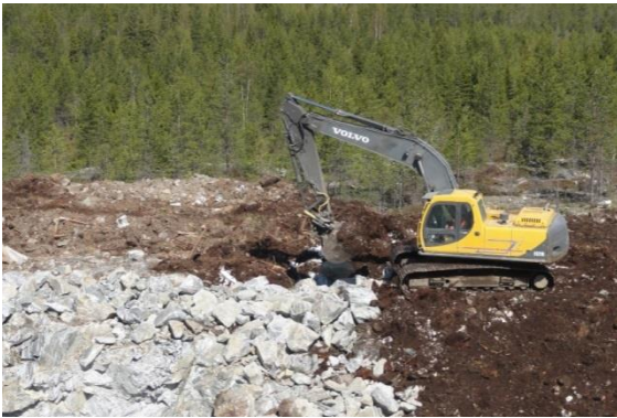
Kuvapari 4-12. Huoltoteiden ja pystytysalueiden rakentamista (kuvat: FCG).
