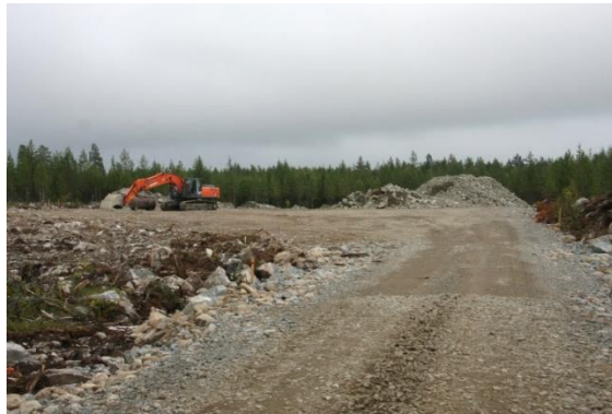
Kuvapari 4-12. Huoltoteiden ja pystytysalueiden rakentamista (kuvat: FCG).
