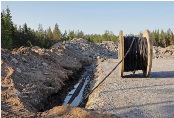
Kuvapari 4-13. Maakaapelit upotetaan huoltoteiden yhteyteen (kuvat: FCG).
