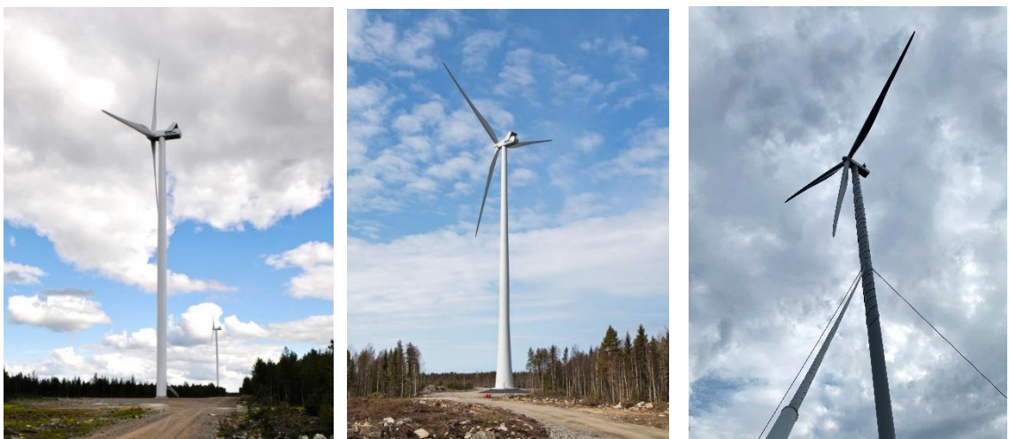
Kuva 4-2. Vasemmalla on esimerkki teräslieriötornista, keskellä hybriditornista ja oikealla harustetusta tornista. (Kuvat: Leila Väyrynen ja Ville Suorsa, FCG sekä Jarkko Finnilä, Carelin)
