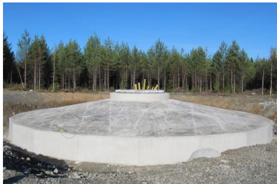
Kuvapari 4-14. Tuulivoimalan perustusten rakentamista. (Kuvat: FCG)
