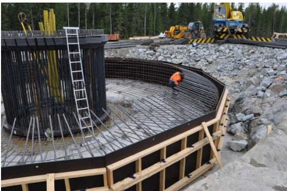
Kuvapari 4-14. Tuulivoimalan perustusten rakentamista. (Kuvat: FCG)
