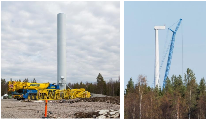
Kuvapari 4-15. Voimaloiden kokoamista (kuvat: FCG).
