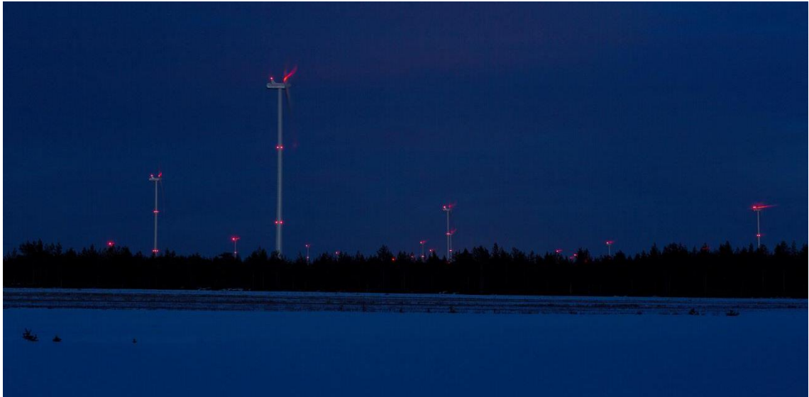
Kuva 4-4. Kiinteät punaiset lentoestevalot. (Kuva: Ville Suorsa, FCG)
