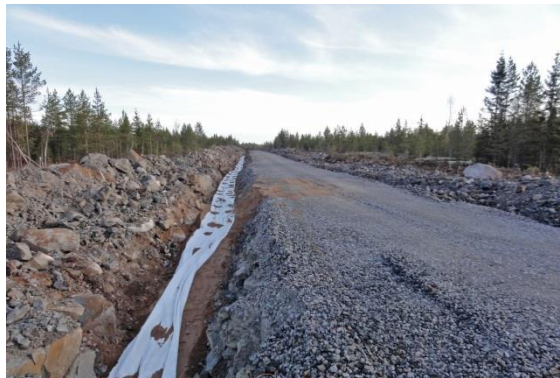
Kuvapari 4-13. Maakaapelit upotetaan huoltoteiden yhteyteen (kuvat: FCG).
