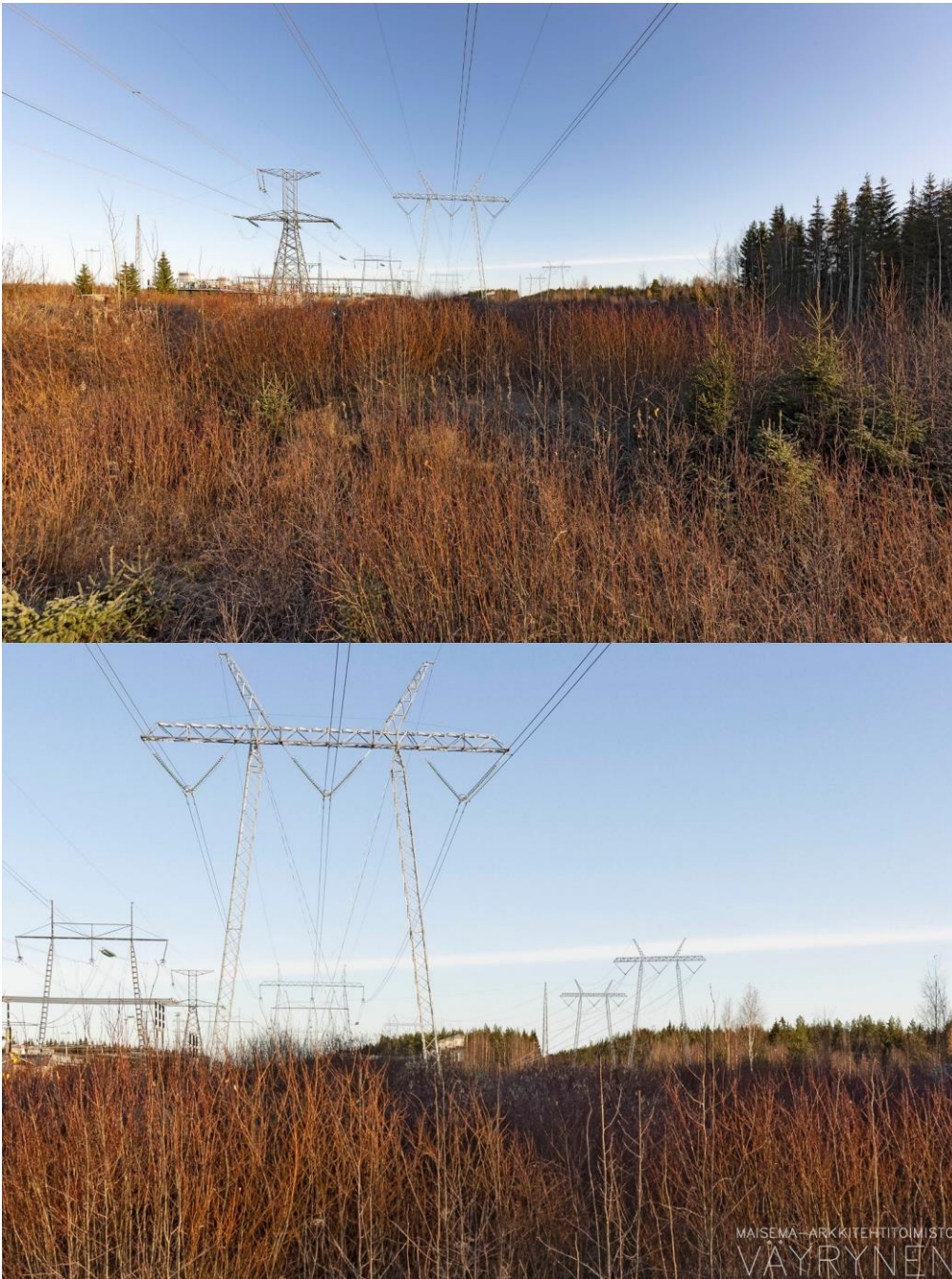
Kuva 8-9 (C). Näkymä voimajohtoihin Uusnivalan sähköaseman eteläpuolelta junaradalta, kuvattuna pohjoisen suuntaan. Hankkeen voimajohto näkyy oikeanpuolimmaisena (yläkuvan objektiivi 16 mm ja alakuvan 50 mm).
