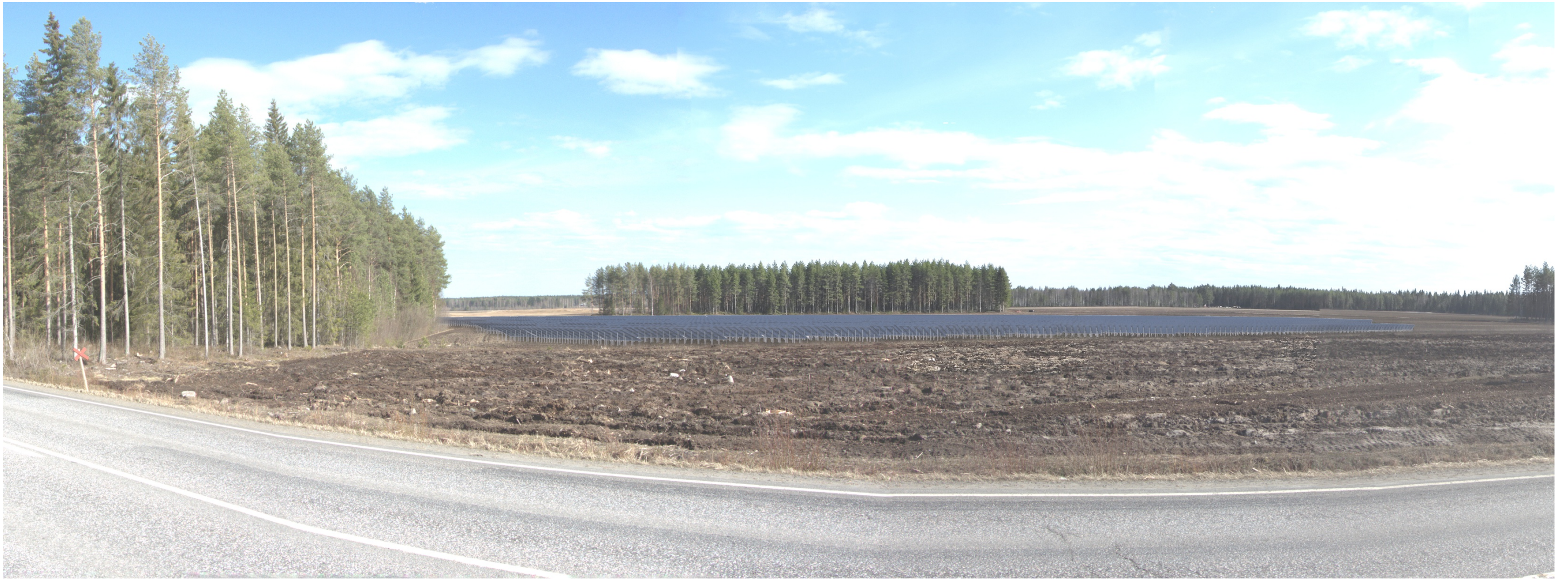
Aurinkopaneelirakennelmat nähtynä Nivala-Kärsämäki-tieltä.
