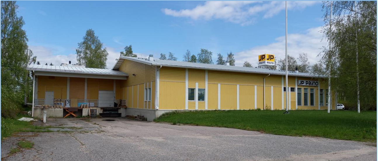
Kuva 5. JP-Painon liikerakennus. © Plandea.
