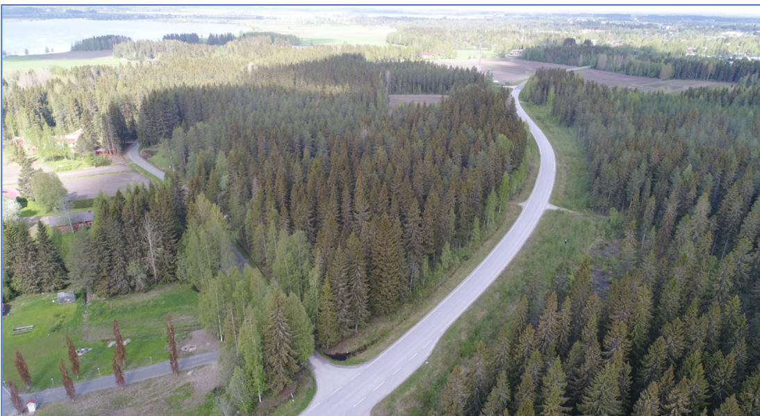
Kuva 8. Pirttirannantien osuus sekä Vanhan Pirttirannantien ja Kotihaantien liittymät kaakosta päin kuvattuna. © Plandea Oy
