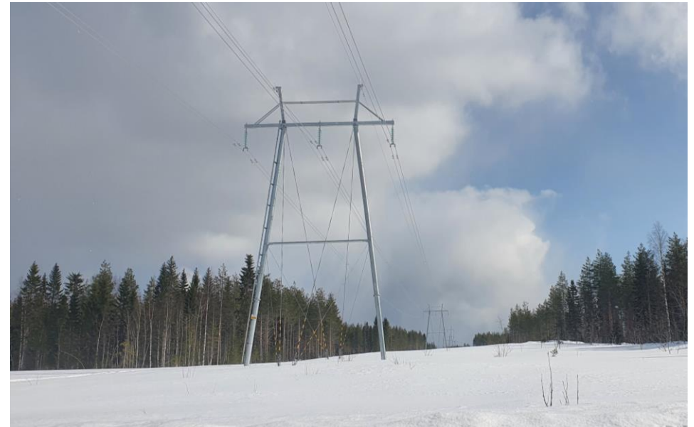
Kuva 8. Esimerkki 110 kV -voimajohtoon maastokäytävästä. © Sweco.
