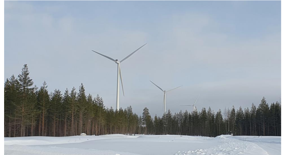
Kuva 9. Kuva Pyhännän ja Kajaanin alueelle sijoittuvasta toiminnassa olevasta Piiparinmäen tuulivoimapuis- tosta. Tuulivoimapuisto sijoittuu kahden maakunnan (Pohjois-Pohjanmaan ja Kainuu) alueelle. Kainuun ja mui- den Pohjois-Pohjanmaan naapurimaakuntien alueella on myös useita suunnitteilla olevia tuulivoimahankkeita. © Sweco.
