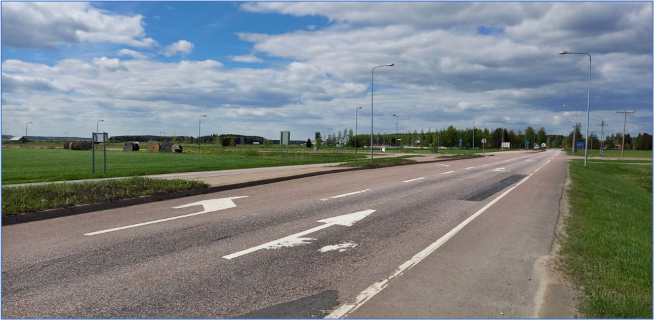
Kuva 8. Tiiliniityntie/Tiilitien -liittymän kanavointi Ylivieskantiellä. © Plandea.
