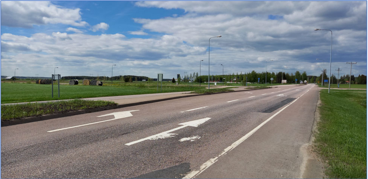
Kuva 8. Tiiliniityntie/Tiilitien -liittymän kanavointi Ylivieskantiellä. © Plandea.
