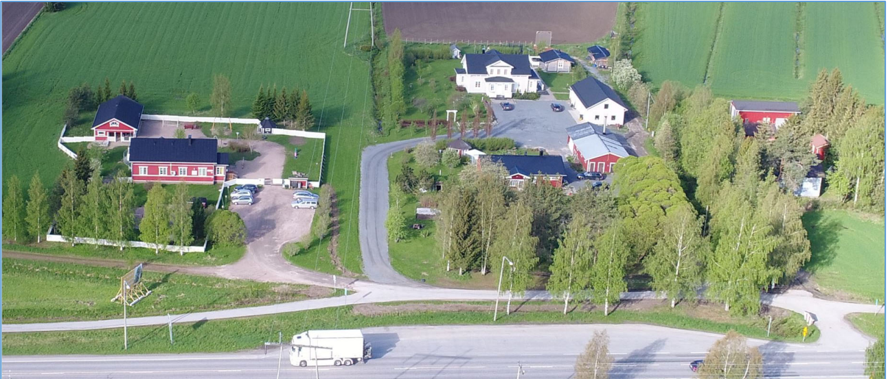
Kuva 6. Ylivieskantien varren pientaloasutusta. Vasemmalla suunnittelualueella sijaitseva pientalo piharakennuksineen (päiväkoti). © Plandea.
