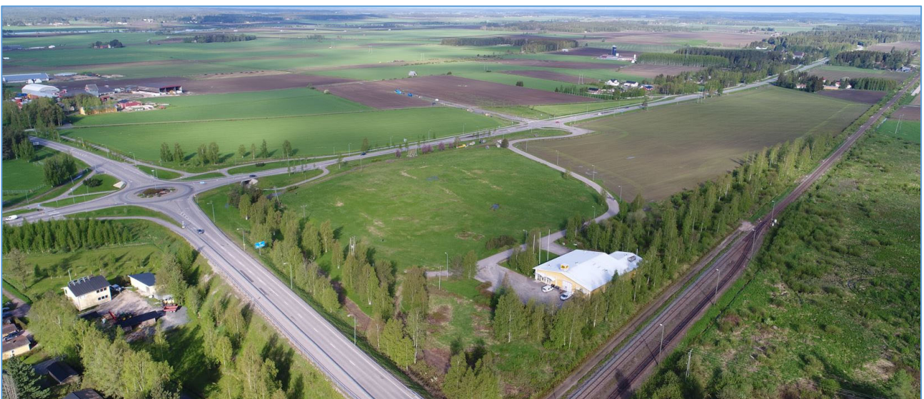
Kuva 2. Näkymä radan ylittävän sillan suunnalta suunnittelualueelle. © Plandea.
