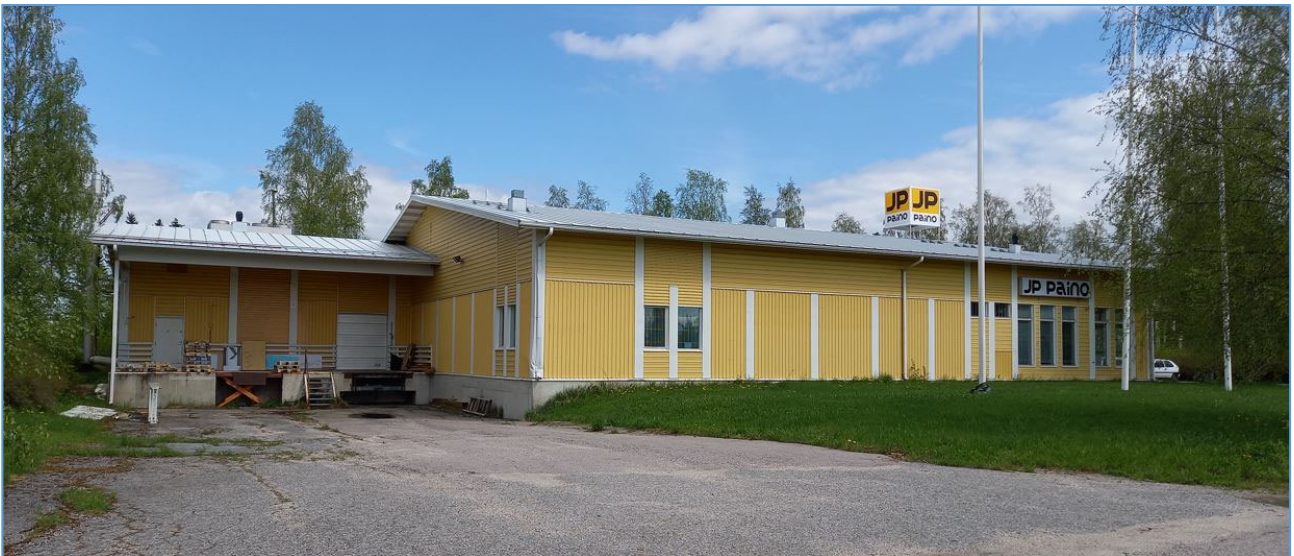
Kuva 5. JP-Painon liikerakennus. © Plandea.
