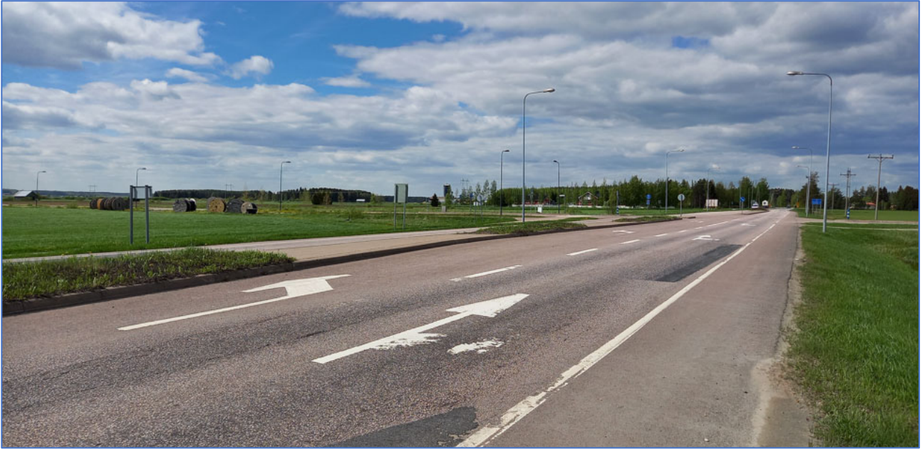
Kuva 8. Tiiliniityntie/Tiilitien -liittymän kanavointi Ylivieskantiellä. © Plandea.
