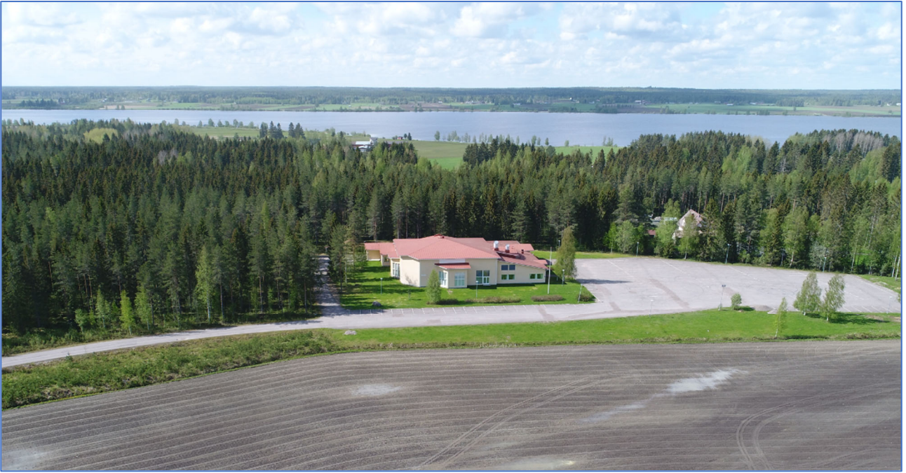
Kuva 3. Nivalan rauhanyhdistyksen rakennus ja pysäköintialue pohjoisesta päin kuvattuna.
