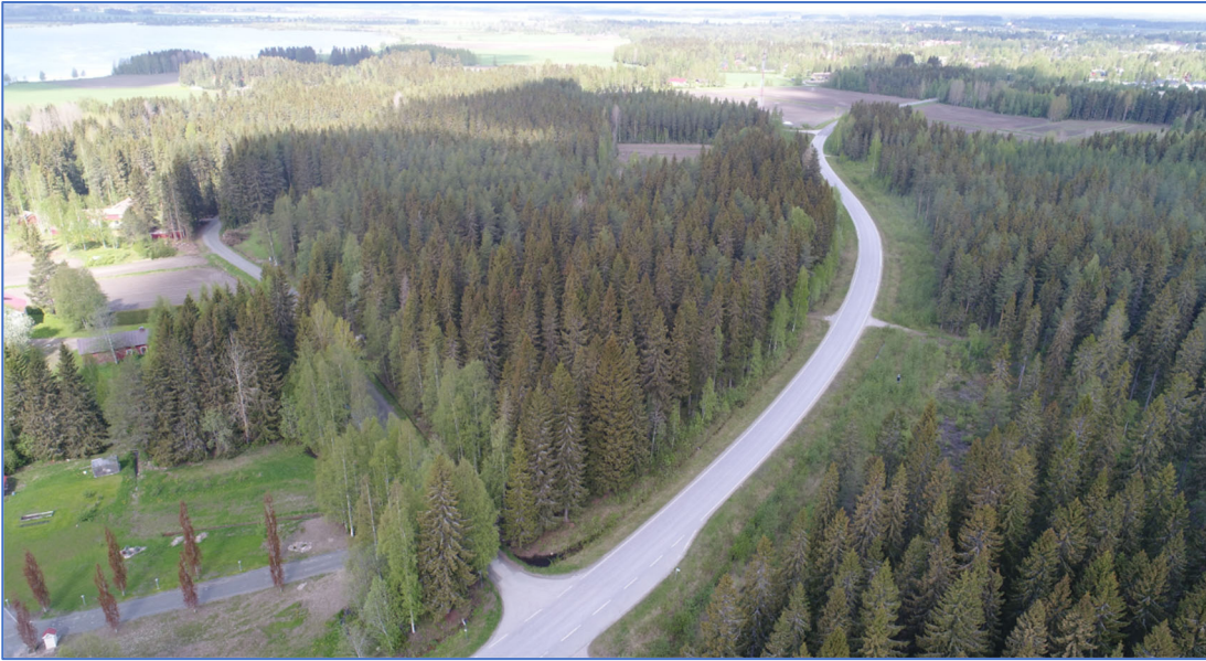
Kuva 7. Pirttirannantien osuus sekä Vanhan Pirttirannantien ja Kotihaantien liittymät kaakosta päin kuvattuna.
