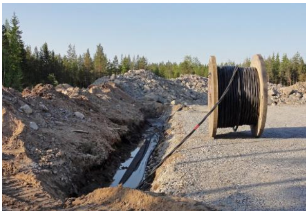
Kuvapari 5.12. Maakaapelit upotetaan huoltoteiden yhteyteen (kuvat: Ville Suorsa/FCG).
