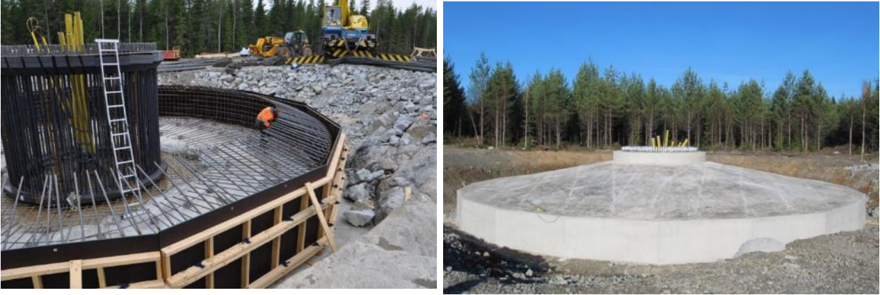
Kuvapari 5.13. Tuulivoimalan perustusten rakentamista. (Kuvat: Leila Väyrynen, FCG)
