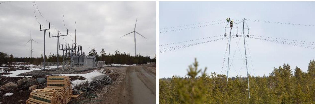
Kuvapari 5.15. Sähköaseman ja voimajohdon rakentamista. (Kuvat: Ville Suorsa, FCG)
