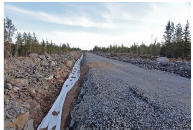
Kuvapari 5.12. Maakaapelit upotetaan huoltoteiden yhteyteen (kuvat: Ville Suorsa/FCG).
