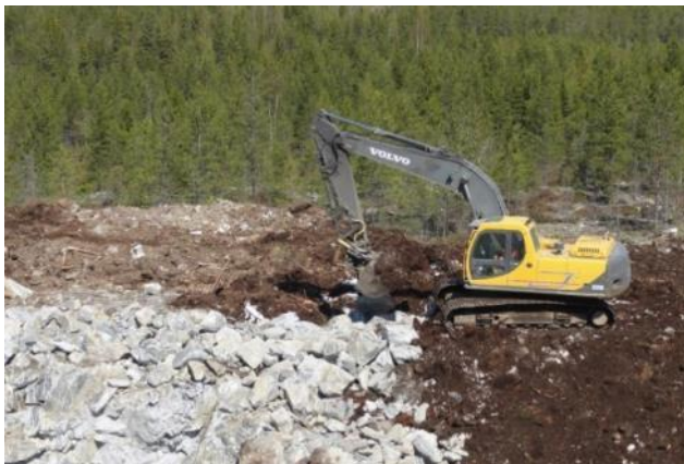
Kuvapari 5.11. Tuulivoimapuiston rakentaminen alkaa huoltoteiden ja pystytysalueiden rakentamisella (kuvat: Ville Suorsa, FCG).
