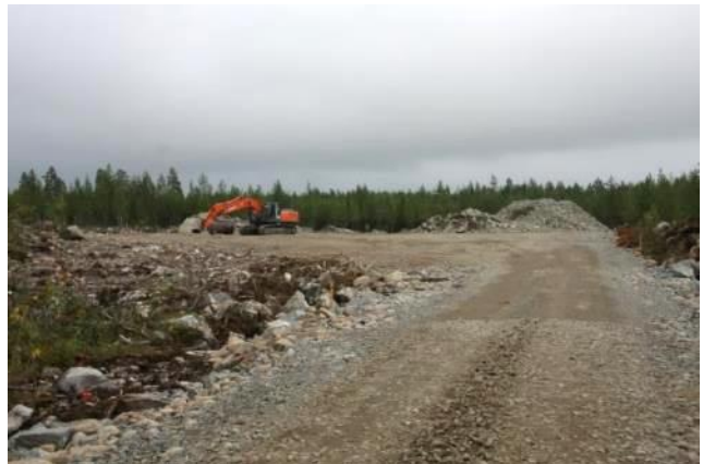
Kuvapari 5.11. Tuulivoimapuiston rakentaminen alkaa huoltoteiden ja pystytysalueiden rakentamisella (kuvat: Ville Suorsa, FCG).
